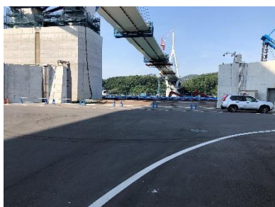
朝日3号陸閘 (全開時)
