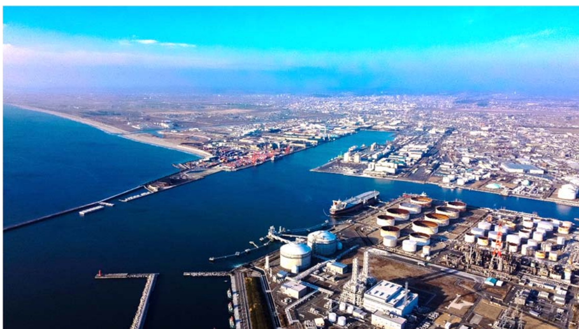
【国際拠点港湾仙台塩釜港】
