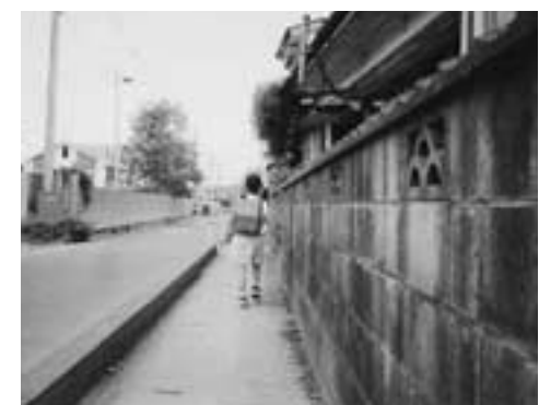
通学路沿いのブロック塀
