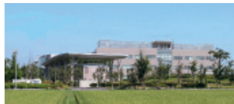
古川農業試験場
