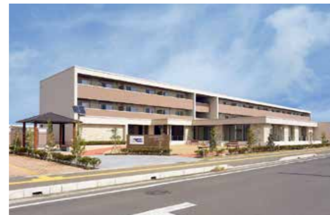
石巻市新蛇田南D地区の災害公営住宅
