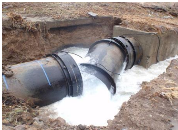
仙南・仙塩広水・伸縮可撓管（白石IC付近）
