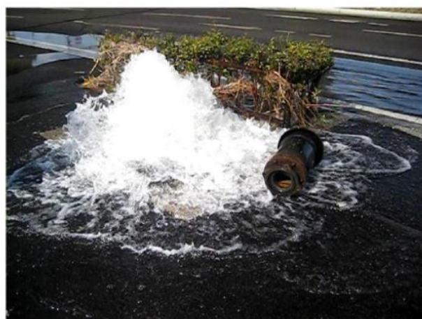
仙台圏工水 空気弁被災箇所
