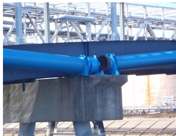
仙塩工水 仙台港水管橋の被害
