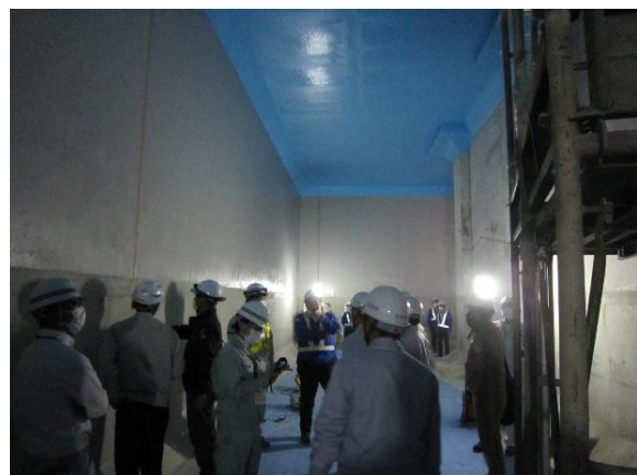
姥ヶ懐調整池内部での現場説明状況
