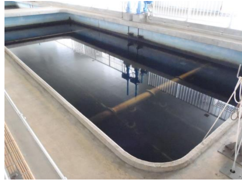
⑤急速ろ過池
