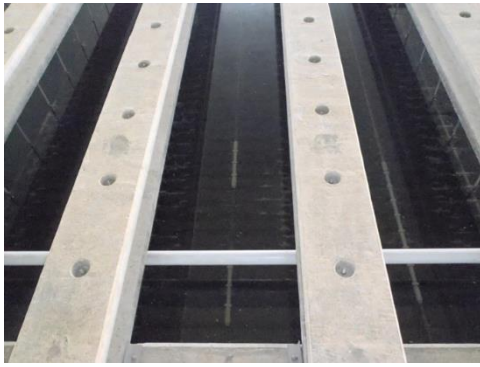
④薬品沈殿池
