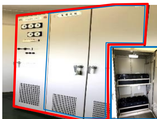
無停電電源装置
