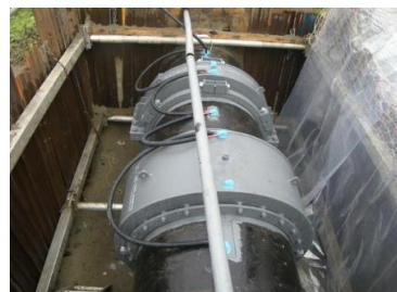
大滝川水管橋左岸側 伸縮可とう管補強
