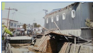
被災直後の建物
