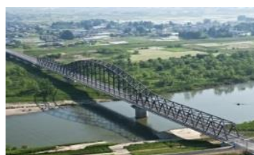
国道113号 丸森大橋 (丸森町)
