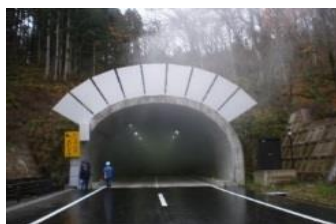
国道108号 荒雄湖トンネル (大崎市)
