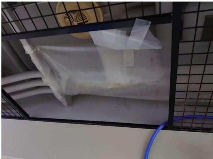
写真 13 雨漏りの補修箇所例 2
