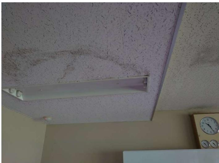
写真 14 雨漏りによって生じたシミ
