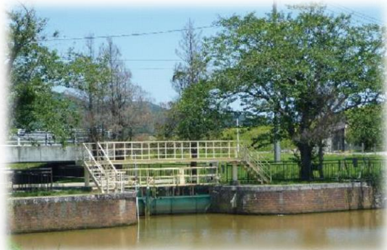
北上運河（石井閘門）
