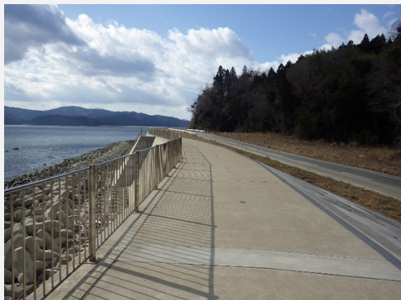
① 平成29年3月 完成
