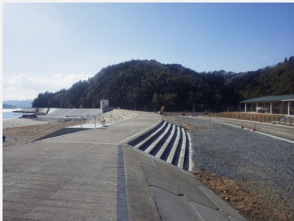
①平成29年3月 完成
