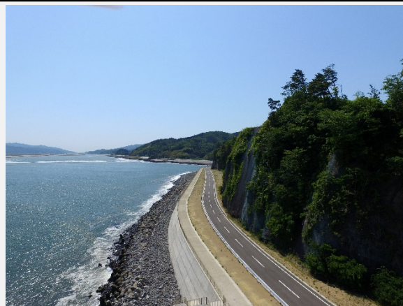
④ 平成28年10月 完成
