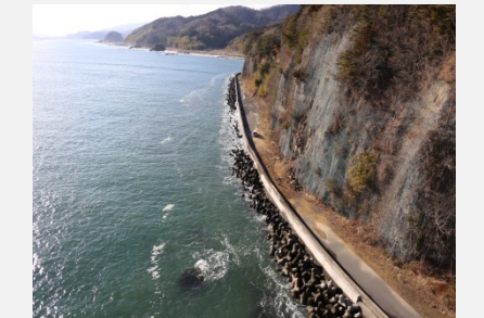
④ 着工前 平成25年2月
