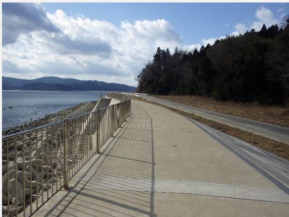
① 平成28年10月 完成
