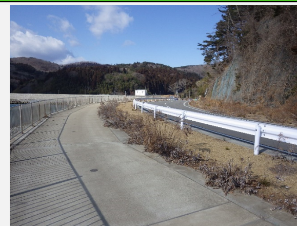
④ 平成29年3月 完成
