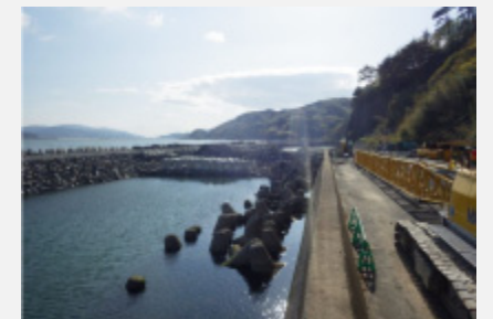
② 着手前 平成25年2月
