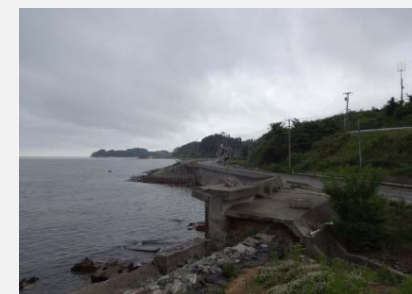
② 着手前 平成26年4月
