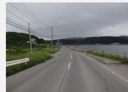
④ 着手前 平成26年4月
