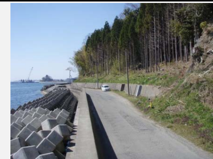
② 着手前 平成26年4月
