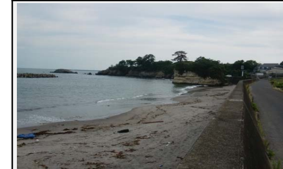
④ 着手前 平成26年5月
