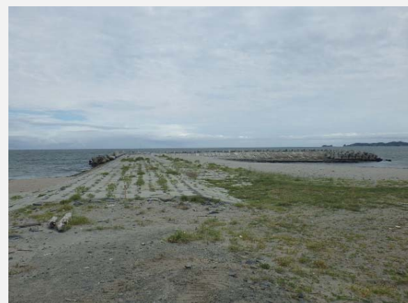
1号突堤の工事が完成しました。
