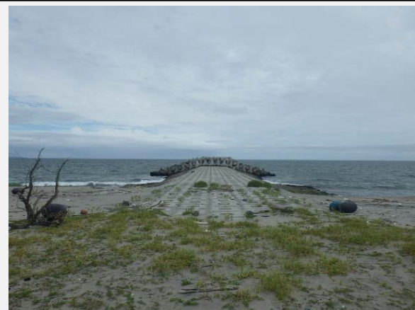
3号突堤の工事が完成しました。
