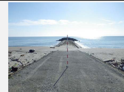
④ 着手前 平成25年6月
