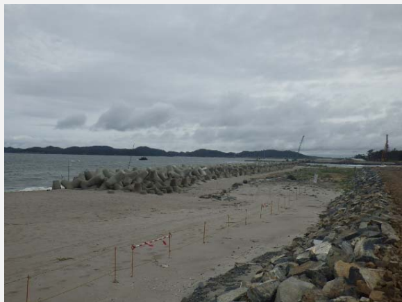
消波堤工の工事が完成しました。
