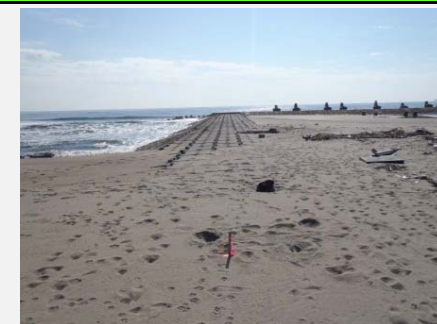
② 着手前 平成25年6月
