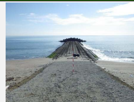
② 着手前 平成24年11月
