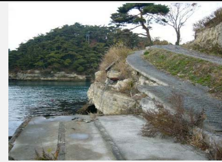
④ 着手前 平成26年10月
