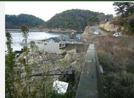
② 着手前 平成26年10月
