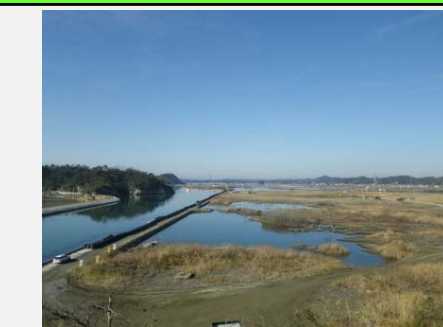
④ 着手前 平成25年4月
