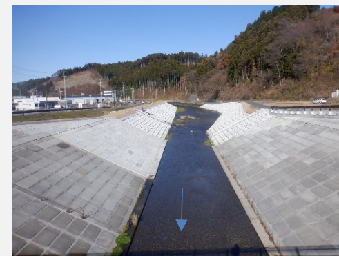
志中大橋付近(上流部)
