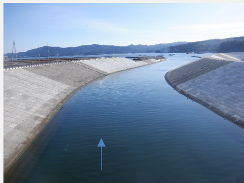
汐見橋付近(下流部)
