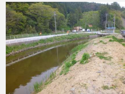
② 着手前 平成25年5月
