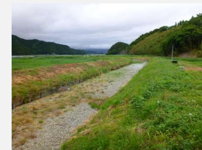
④ 着手前 平成25年5月
