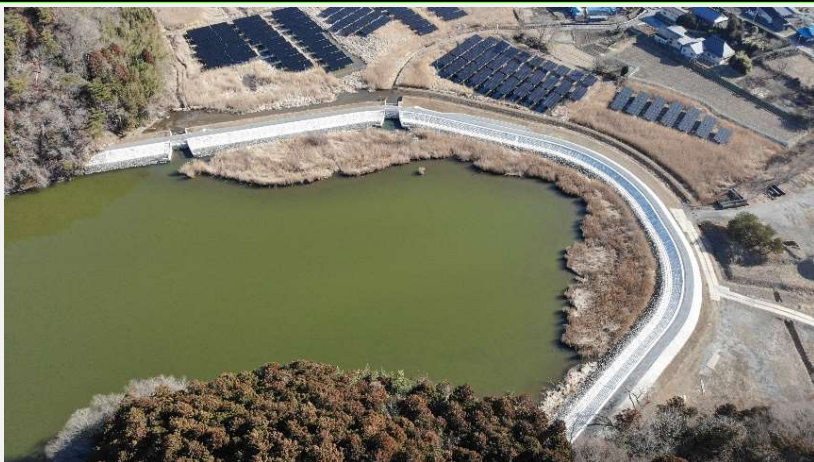
1・2工区状況(完了)
