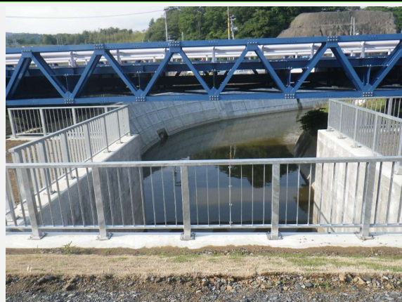
完成しました。(函体上部から翼壁, 下流を望む)
