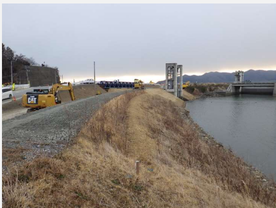
施工区間4 植生が回復しています。
