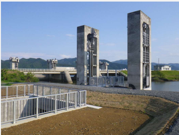
完成しました。(門柱, 函体部を望む)
