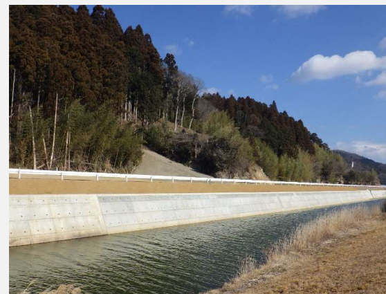
施工区間1 上流側 工事が完了しました。
