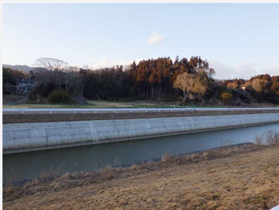
施工区間1 下流側 工事が完了しました。
