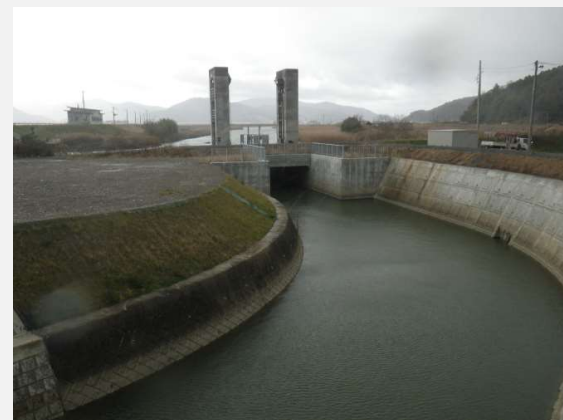
施工区間3 関係工事も全て完了しました。
