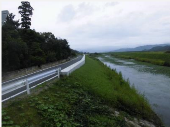
馬鞍橋下流 法覆護岸工、特殊堤が完成しました。
