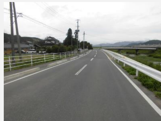
馬鞍橋下流 舗装工が完了しました。
