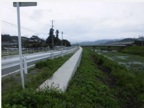
馬鞍橋上流 法覆護岸工、特殊堤が完成しました。
