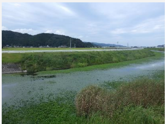
左岸No.49付近 河岸の植生が回復しています。
