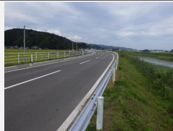
左岸No.49付近 舗装工が完成しました。
