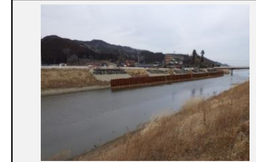
④ 着手前 平成31年2月
