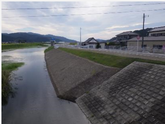
左岸No.45付近 法覆護岸工が完成しました。
