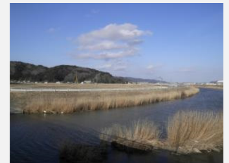
④ 着手前 平成30年4月
