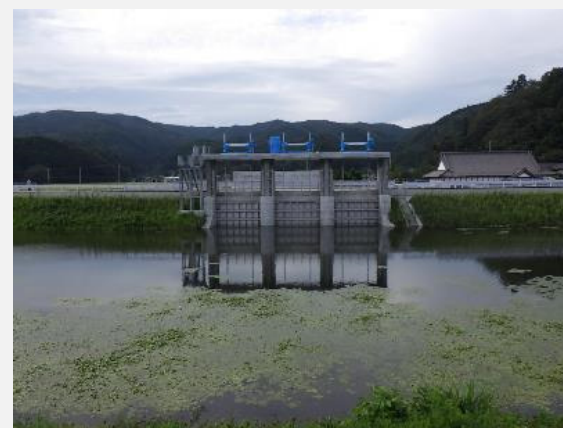
西沢川樋門(新)が完成しました。
