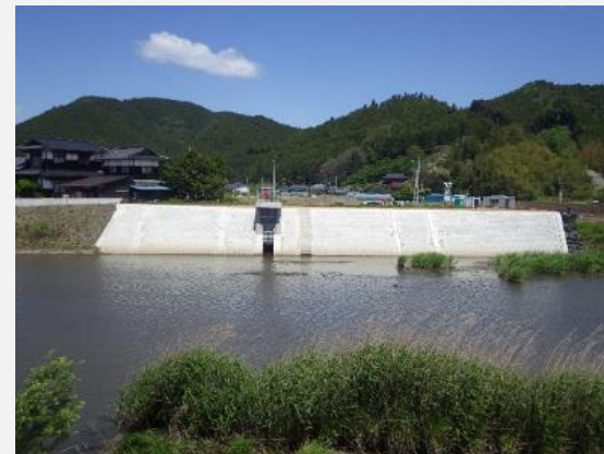
馬鞍天満前樋管が完成しました。
