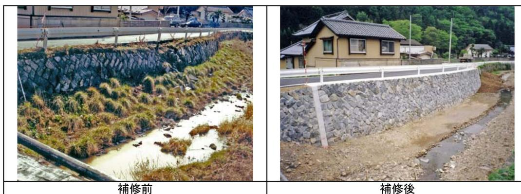
図 2-21 河道の維持管理（護岸の補修：真野川）
