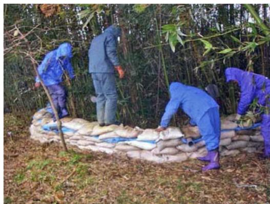
図 2-23 洪水時の対応状況（月の輪工：富士川の事例）
