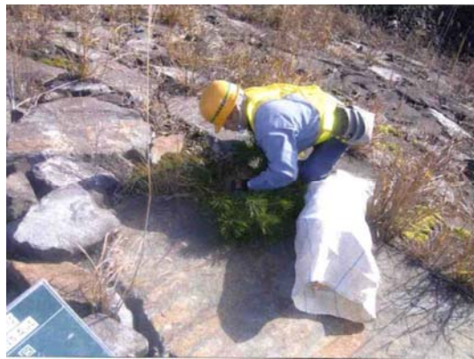
堤体の植生除去(荒砥沢ダム)
