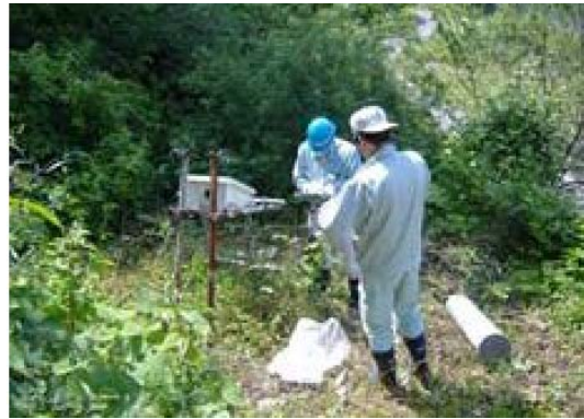
地山の地下水位観測(小田ダム)
