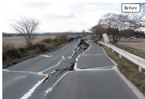
被災状況(平成23年3月撮影)
