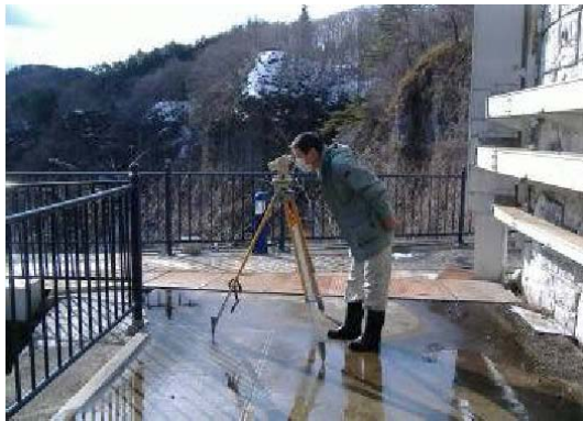
堤体変位の観測(花山ダム)
