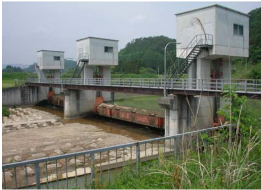
一の堰頭首工下流の瀬切れ(二迫川)
