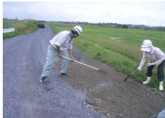
堤防補修の様子
