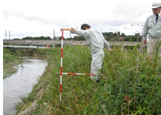
堤防点検(照越川)
