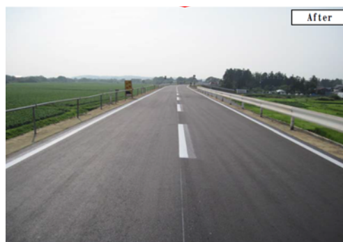
復旧状況(平成23年8月撮影)
