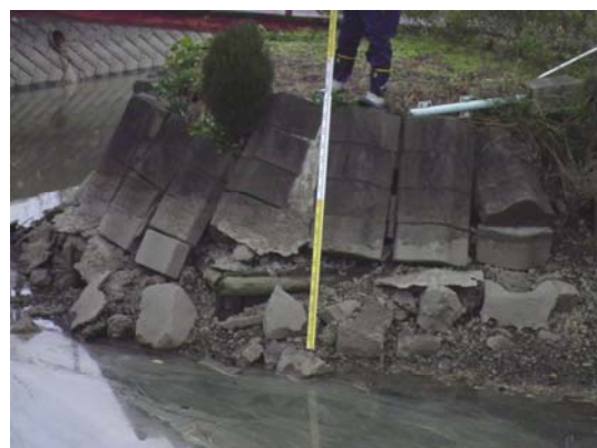
護岸損傷状況の調査
