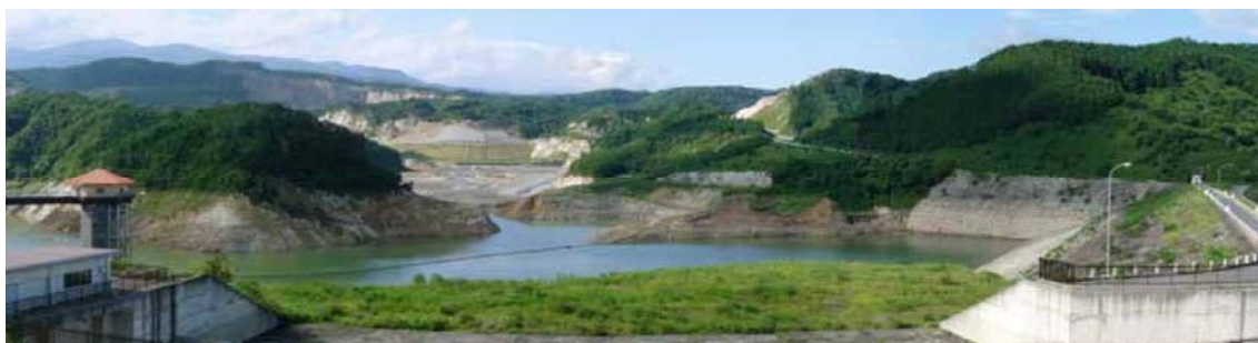
復旧状況(平成22年8月17日撮影)
