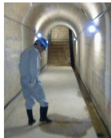
荒砥沢ダム 監査廊点検
