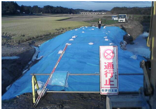
堤防補修の様子(照越川)
