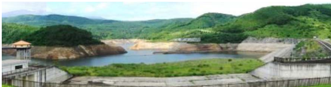
地震発生前(平成19年9月3日撮影)
