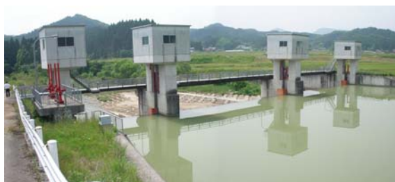
一の堰頭首工(二迫川)
