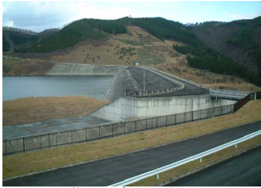
荒砥沢ダム(二迫川)
