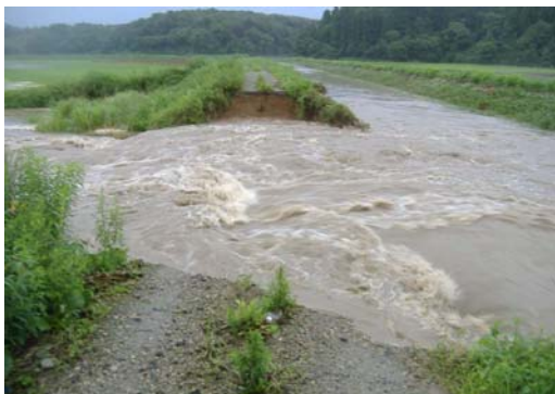
照越川破堤状況(栗原市築館照越地内)
