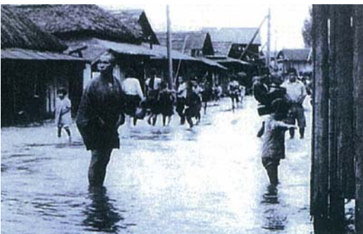
迫川は10~20日もの間浸水した(旧若柳町)
