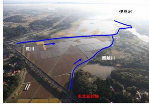
伊豆沼上流の荒川、照越川周辺の冠水状況)
