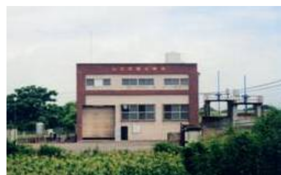
山吉田揚水機場(迫川)
