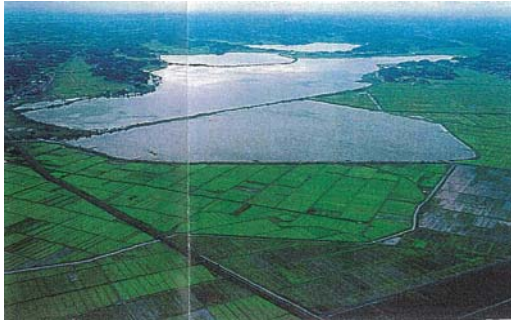
伊豆沼(第2工区、第3工区に越流)
