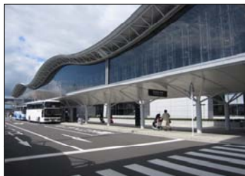
H23.9.25 完全復旧した旅客ターミナルビル
