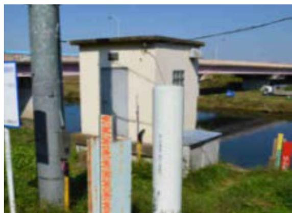
水位計・河川監視カメラ等の整備状況
