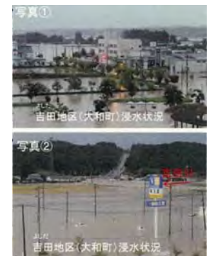
台風19号での浸水被害
