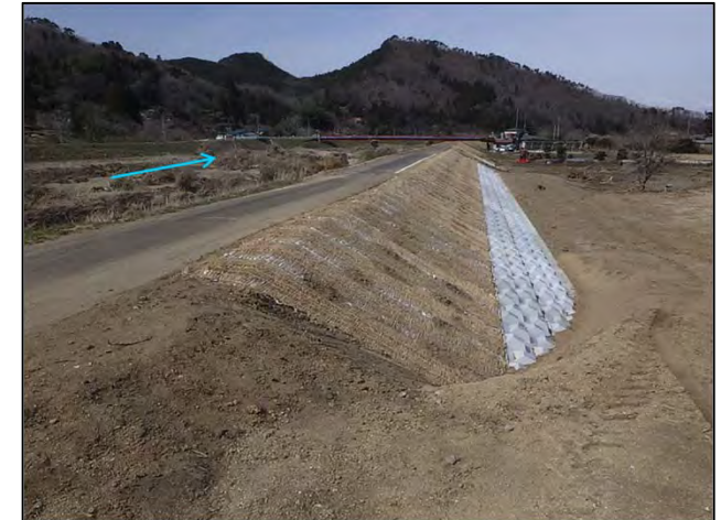
図：法尻補強の事例(雉子尾川)
