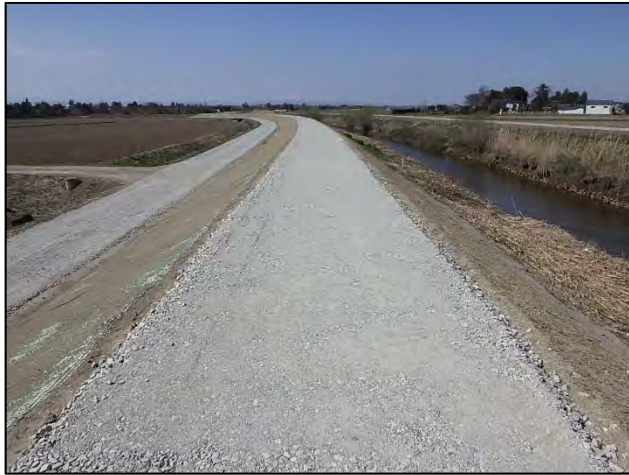
図：堤防嵩上げの実施例（渋井川）
