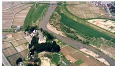
中流域の状況 (39km 付近)
