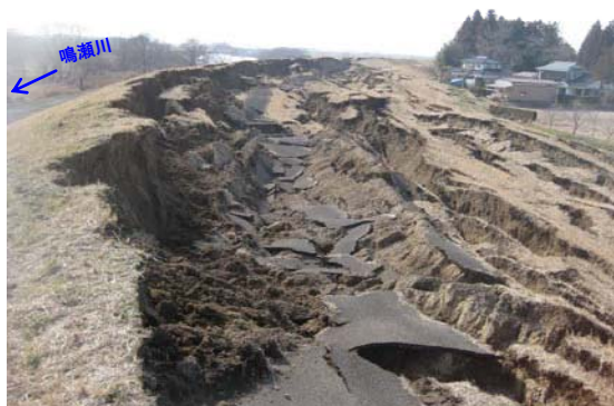
写真 2-25 鳴瀬川左岸 30.3k 付近
