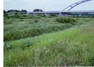
写真 2-29 背割堤防区間の植生状況
