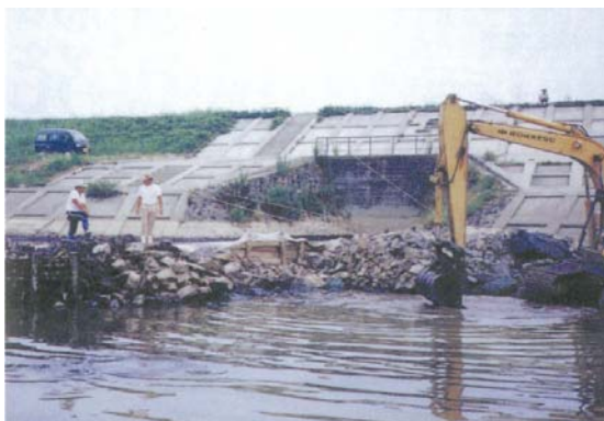
写真 2-16 かんがい取水口前面の堆積土砂 撤去作業 旧南郷町（美里町）
