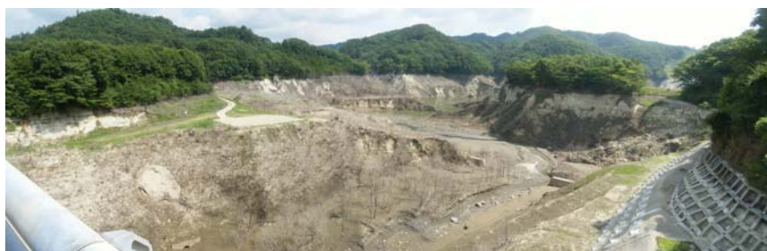
写真 2-19 干上がった「二ツ石ダム貯水池」
