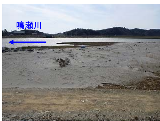
写真 2-37 河口部左岸高水敷の状況
