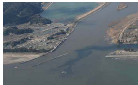
被災後河口部付近の状況
