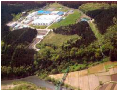
写真 2-8 ふもとやま 籠山浄水場
