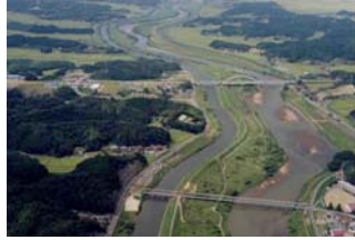
写真 2-28 背割堤の状況
