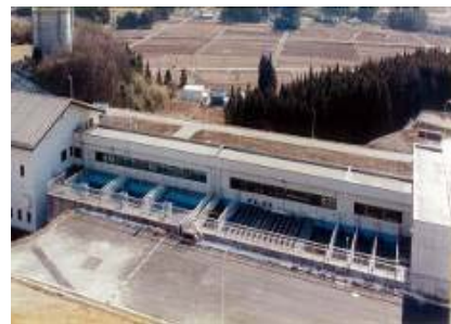
写真 2-9 なかみね 中峰浄水場
