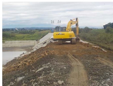
応急復旧状況
