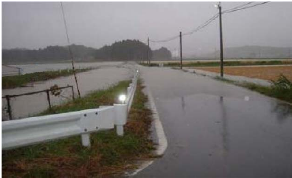
写真 1-2 平成 18 年 9 月洪水時の冠水状況（坂元川）
