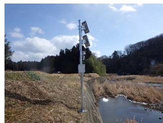
設置状況（七北田川）
