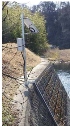
設置状況（七北田川）
