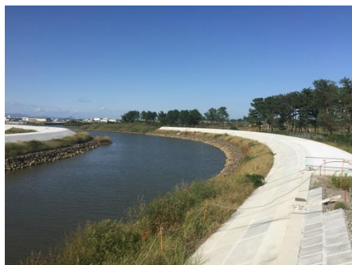
寄石・覆土状況
