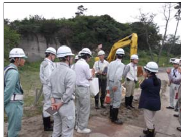
現場における環境保全実施状況説明
