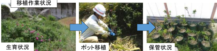
移植作業状況
