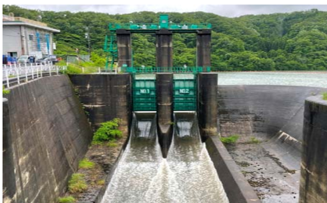
樽水ダム常用洪水吐
