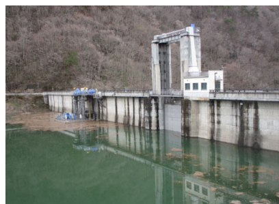
貯水池 ダム堤体上流 (撮影:4月15日10時20分)
