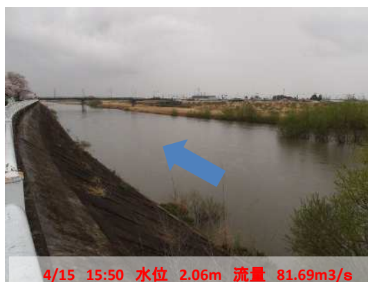
4/15 15:50 水位 2.06m 流量 81.69m³/s 【洪水後】花山ダム下流 若柳水位観測所(下流を望む)
