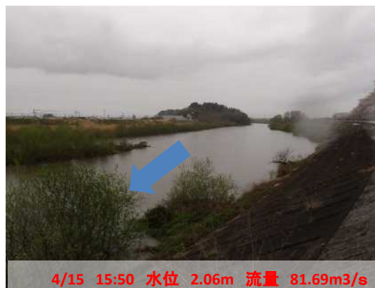
4/15 15:50 水位 2.06m 流量 81.69m³/s 【洪水後】花山ダム下流 若柳水位観測所(上流を望む)
