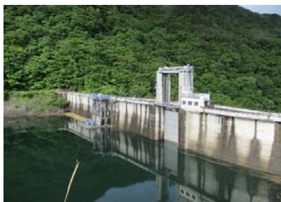
貯水池 ダム堤体上流 (撮影:5月27日15時)
