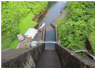
放流設備 ダム堤体下流 (撮影:5月27日15時)
