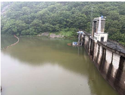
貯水池 ダム堤体上流 (撮影:6月22日10時00分)
