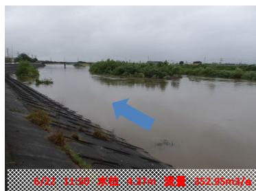
【洪水後】花山ダム下流 若柳水位観測所(下流を望む)
