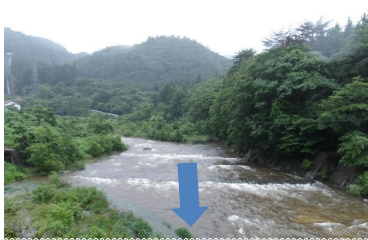
【洪水後】花山ダム上流 山内水位観測所(上流を望む)
