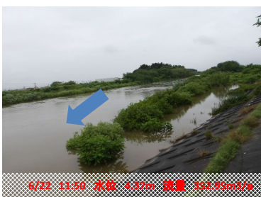
【洪水後】花山ダム下流 若柳水位観測所(上流を望む)
