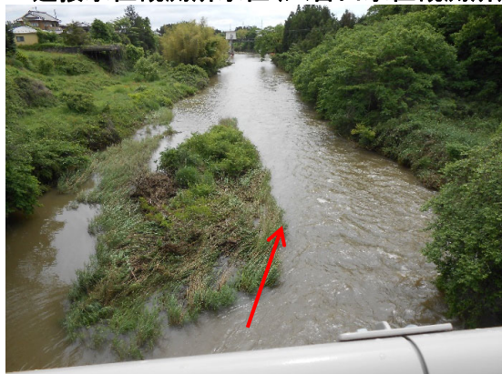
吉田川(魚板橋下流)(洪水後6月1日10時30分) 近接水位観測所水位(八合田水位観測所)
