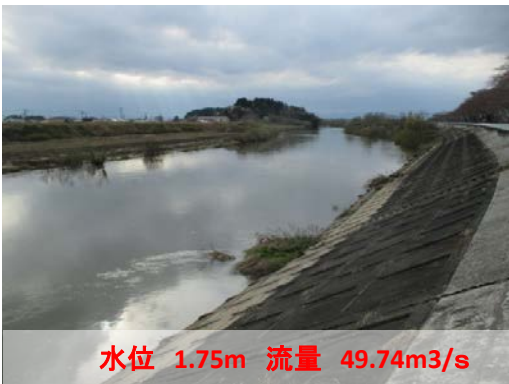
花山ダム下流 若柳水位観測所(上流を望む)
