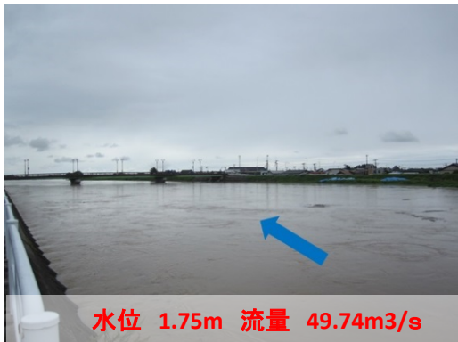
花山ダム下流 若柳水位観測所(下流を望む)
