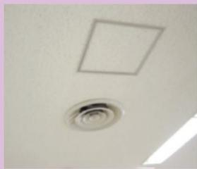
石綿含有ロックウール吸音天井板
