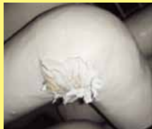
石綿含有保温材 (配管エルボの保温材)
