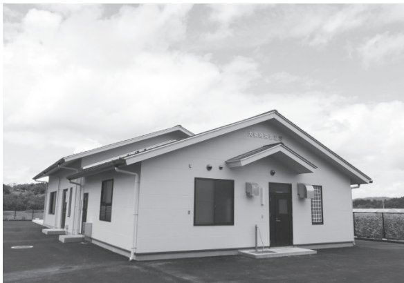
▲大泉地区污水处理施設（登米市）
