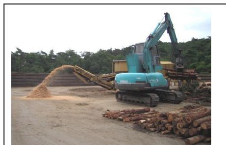
自走式木材破碎機等による木材チップの製造作業
